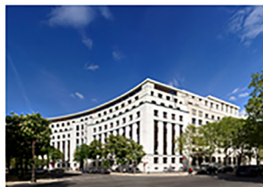
Ilôt Ségur Fontenoy : immeuble restructuré abritant les services du Premier ministre
