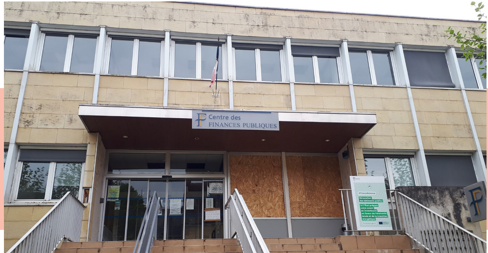
Maison de l'État de Nogent-le-Rotrou (Eure-et-Loir - 28)
