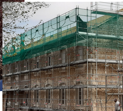
Rénovation d'une partie des bâtiments de la cité administrative Bertrand à Châteauroux (Indre)
