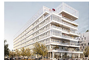
Insight Bordeaux : bâtiment pris en exploitation maintenance par l'AGILE
