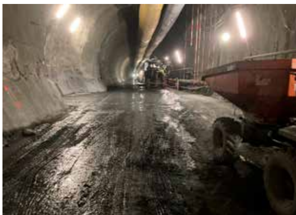
La construction du tunnel euralpin Lyon-Turin.
